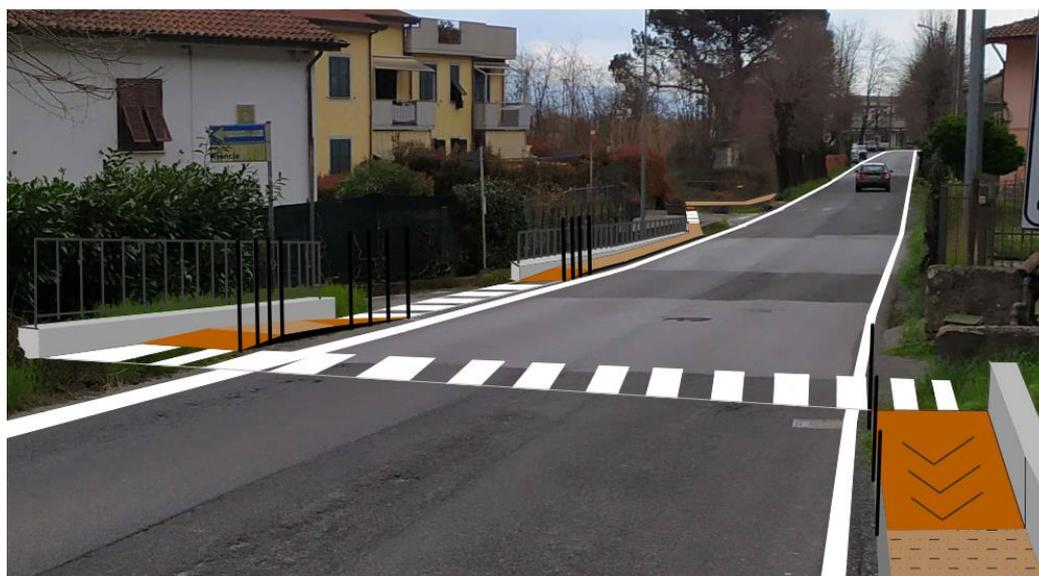
Dal fotoinserimento è possibile vedere come le previsioni progettuali rispecchino quanto sopra relazionato ed in particolare , in corrispondenza del distributore di carburante esistente , verranno posti in opera parapetonali singoli nella rampa di raccordo seguiti dalla segnaletica orizzontale in corrispondenza degli accessi ; nel tratto in cui causa la limitata larghezza non è possibile realizzare il marciapiede rialzato verranno posti in opera parapetonali ad arco così come sopra individuati.
